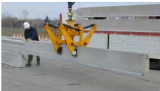
Montering med gripare för skyddsbarriärer
